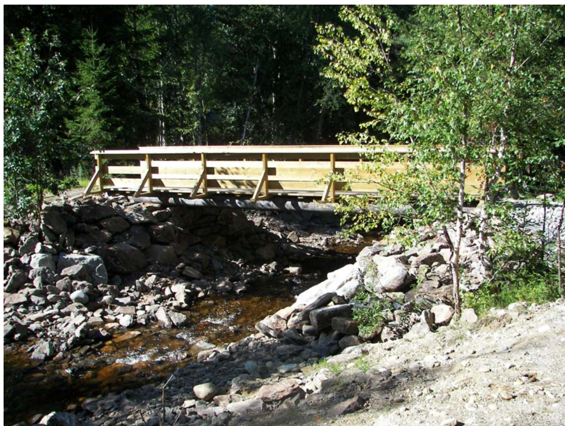
Ny bru over Bollunga ved Kløftvollen.
